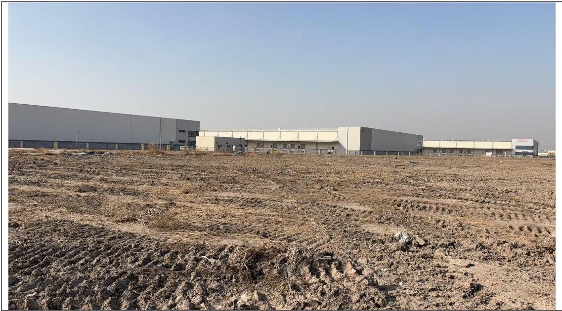
图 2.4-1 项目现场现状
